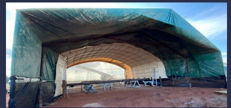
Sandblasting y Pintura 60 m x 20 m = 1.200 m 2
